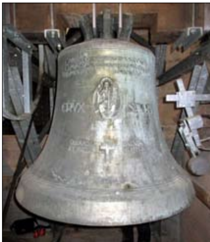
Glocke 2 „Hl.-Kreuz-Glocke“ mit Ton g', gegossen 1950, Gewicht 726 kg, Durchmesser 105,4 cm
